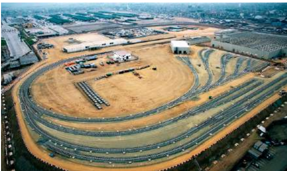
Línea 2 del Metro de Lima Patio taller
