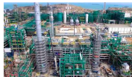
PETROPERÚ Refinería de Talara
