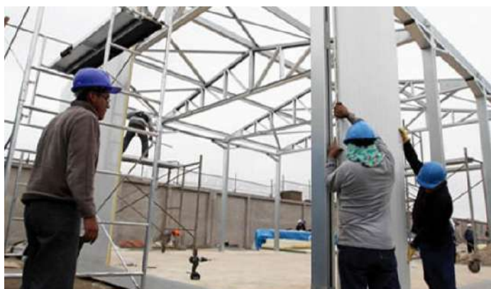
PRONIED - SELVA DEL PERÚ CLIENTE: NEXOS COMERCIALES PESO: 350 Tn. galvanizado
