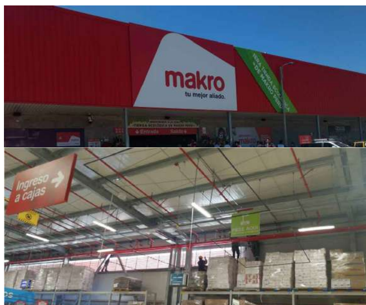
CONSTRUCCIÓN METÁLICA DEL CENTRO COMERCIAL MAKRO - ICA
