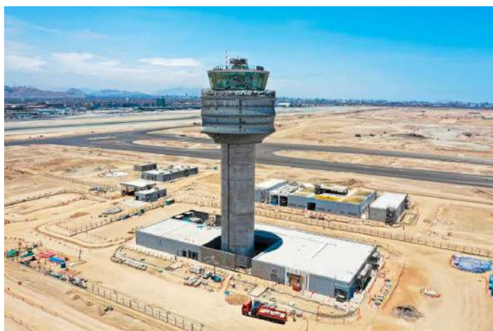
TORRE DE CONTROL - AEROPUERTO JORGE CHÁVEZ CLIENTE: JCB ESTRUCTURAS PESO: 300 Tn. galvanizado
