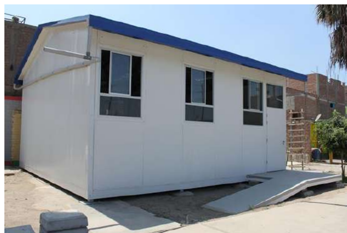
PRONIED - SELVA DEL PERÚ CLIENTE: E Y C METÁLICAS PESO: 475 Tn. galvanizado
