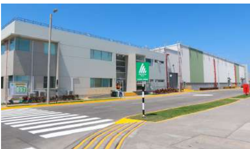
Planta Obra PROTISTA Cañete
