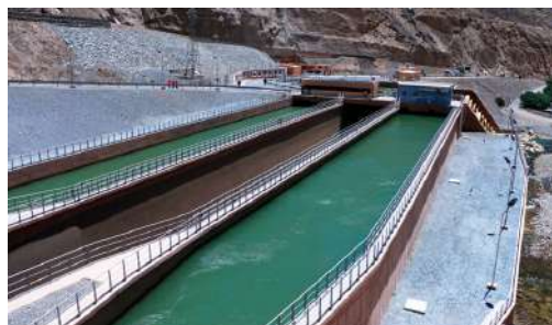
Central Hidroeléctrica De Olmos
